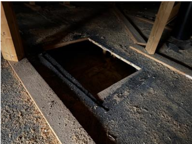
Inspektionshål i gamla taket.
