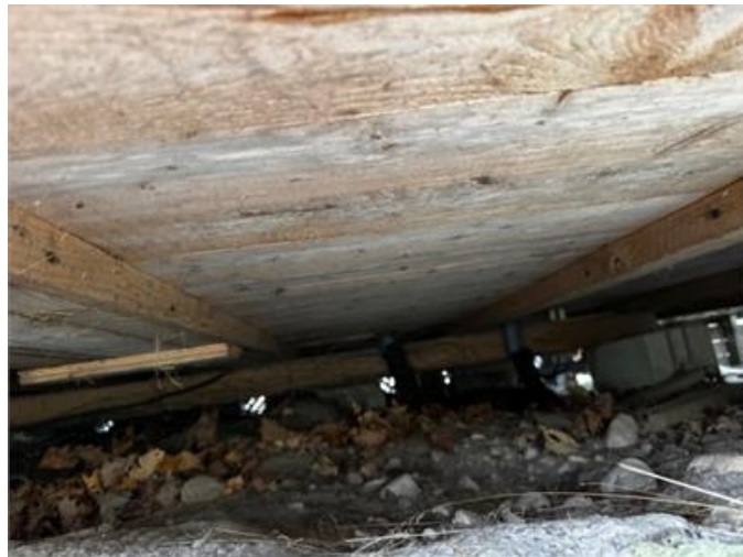
Plintgrund huvudbyggnad låg del.
