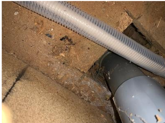
Kontroll av konstruktionen via hål i diskbänksskåp.
